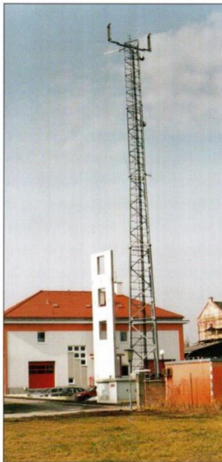
Neues Feuerwehrhaus 1999 mit Kletterwand und neuem Funkmast
