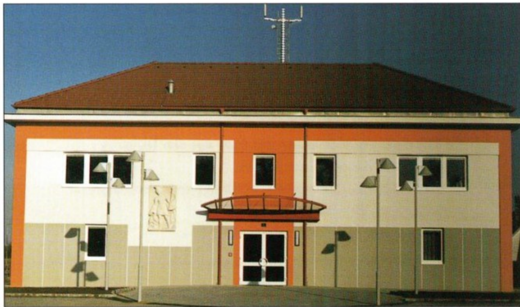
Neues Feuerwehrhaus 1999 mit Vorplatz und Floriani-Relief
