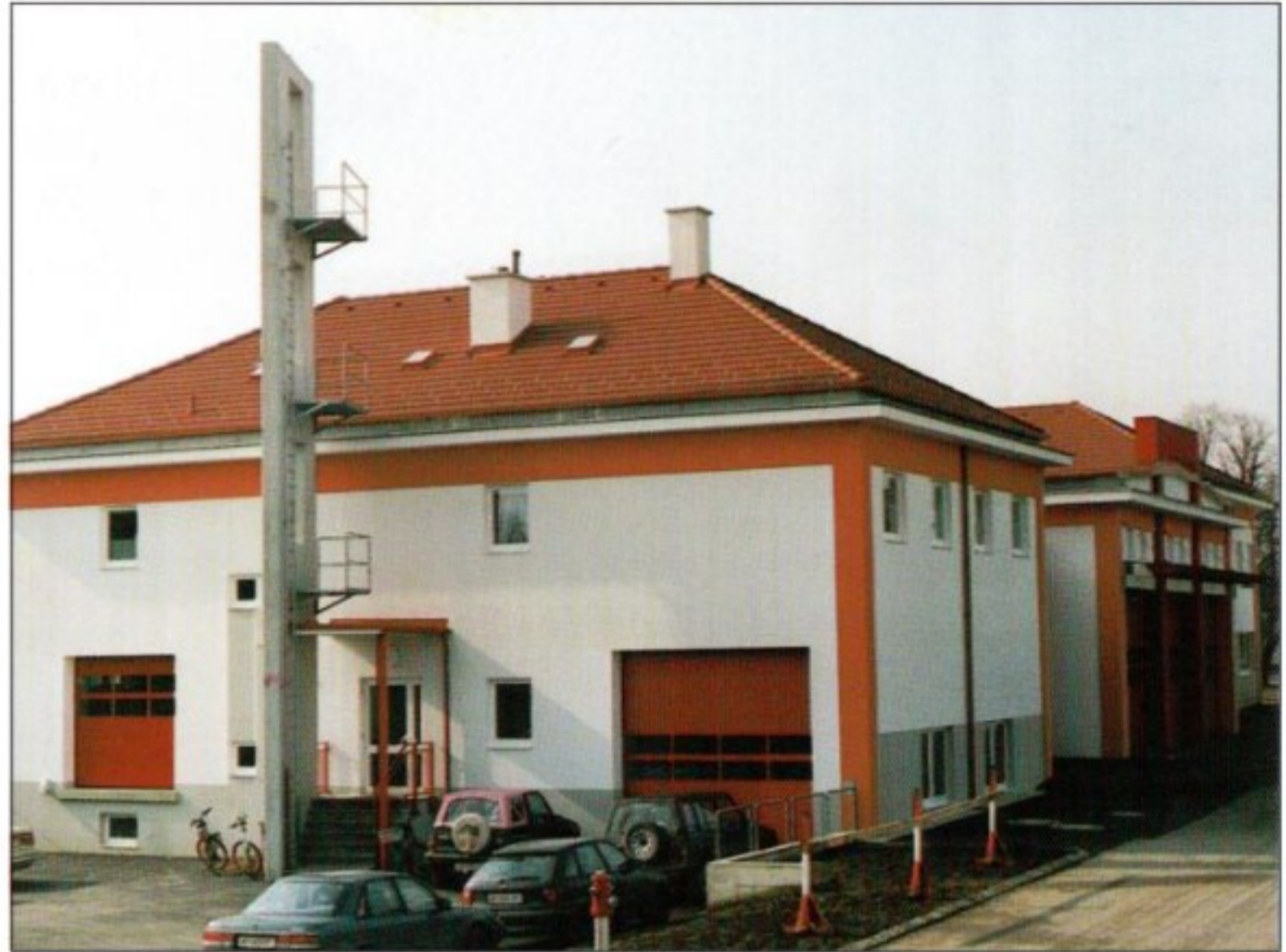
Neues Feuerwehrhaus 1999 mit Übungswand (Ostseite)
