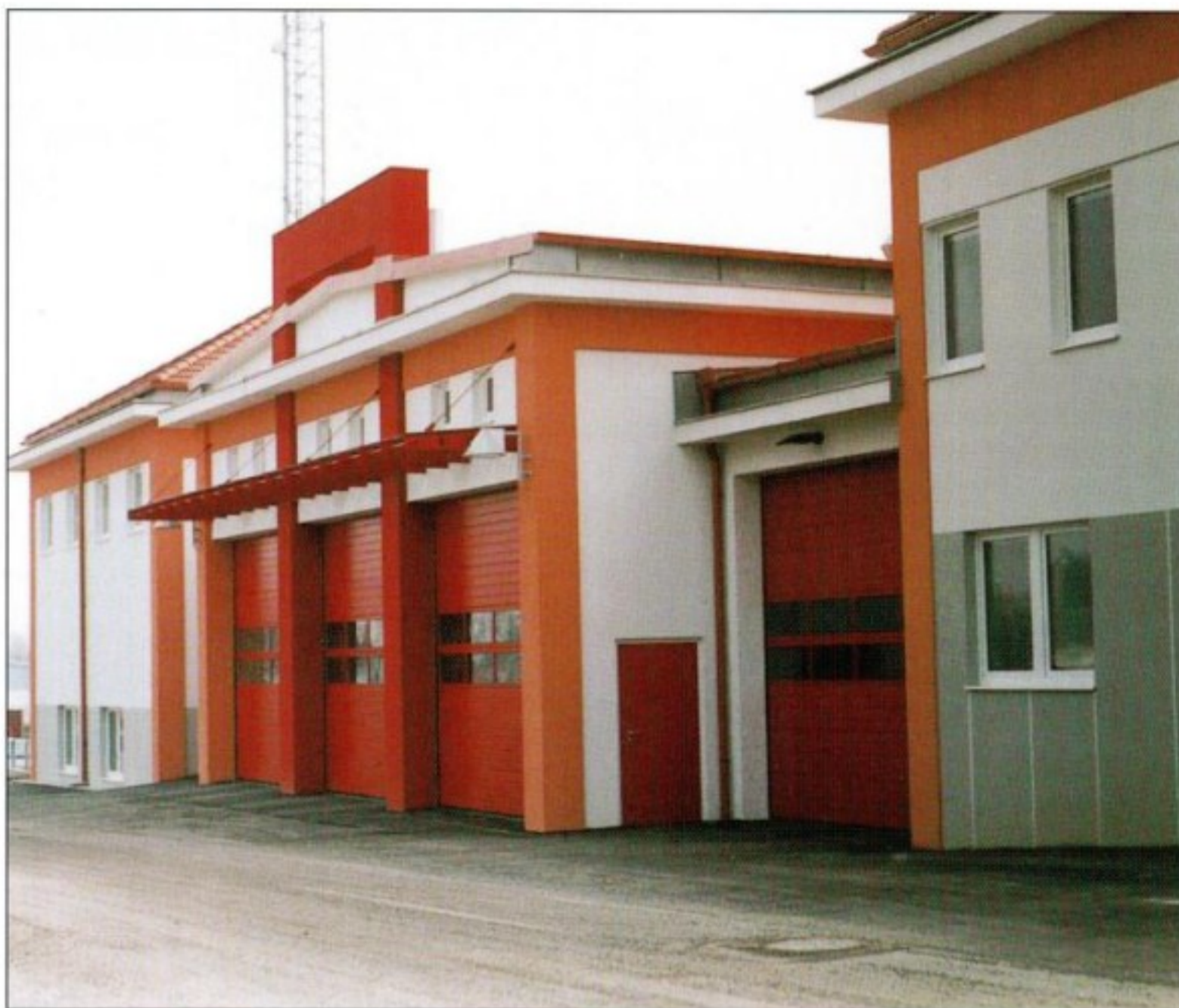
Feuerwehrhaus mit Ausfahrtstore (Nordseite)
